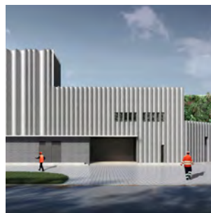
廣州金湖花園垃圾壓縮站
