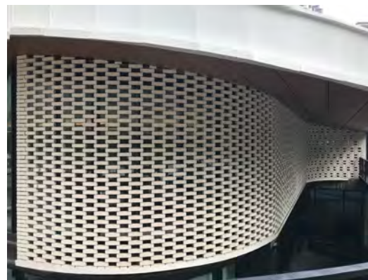
黏土磚構造出遮陽屏，外掛於落地大窗外
