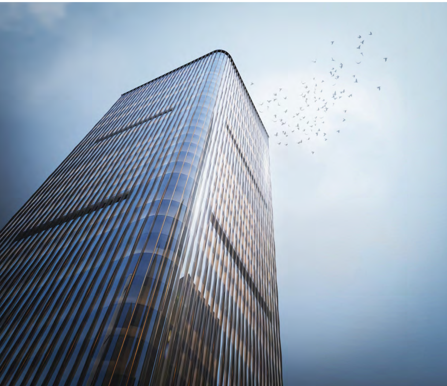
直樑以兩片鋁片如波浪般交替 外懸，形成針織一般的效果
