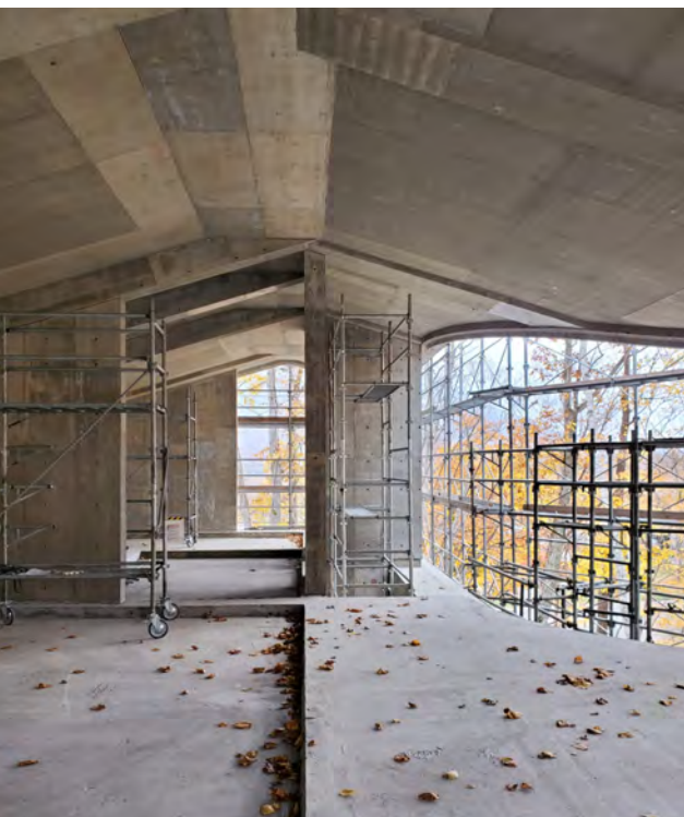
◀ 混凝土框架完成， 室內外分隔清晰可見
